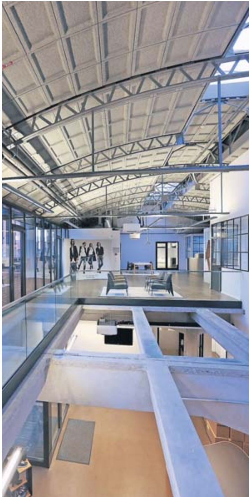
Die Räume für ein Mode-Unternehmen zeigen das Sanierungsprinzip: Die alte Konstruktion wurde in die neue Aufteilung einbezogen. RP-FOTOS: HANS-JÜRGEN BAUER
